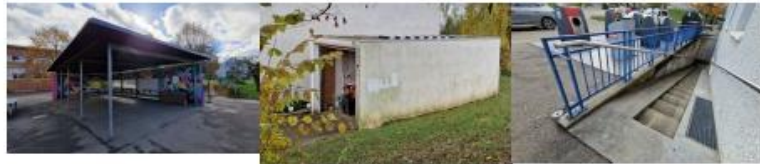
Pausenhalle Dorf, Velounterstand / 00716 Dorfstrasse Fertigarage / 00832 Lägernbreite Heizungskeller, Tankraum / 00843 Dorfstrasse 16
