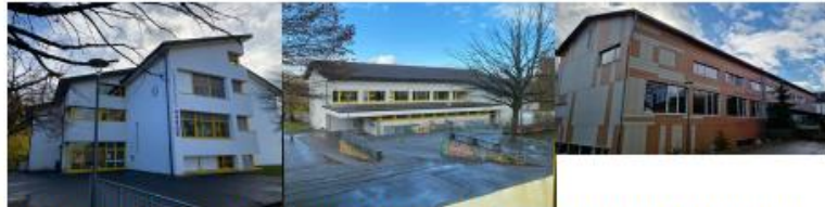
Schulhaus Lägernbreite / 00357 Breitenstrasse 5 Turnhalle Lägernbreite / 00358 Lägernbreite Schulhaus Kindergarten Brühl / 00650 Dorfstrasse 6
