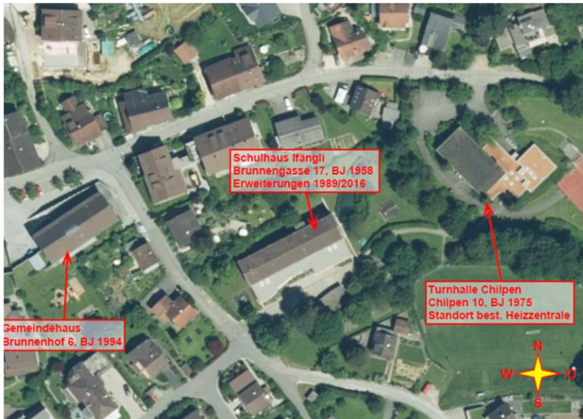
Nahwärmeverbund (NWW) bestehend aus drei Gebäuden Turnhalle, Schulhaus und Gemeindefhaus
