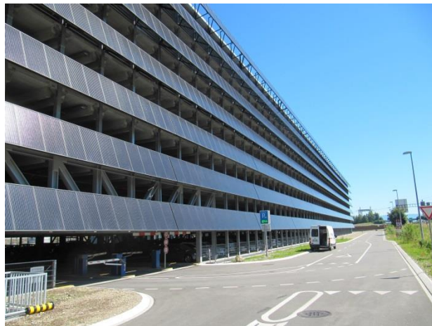
Abb. 17 Solarstromanlage, die in das architektonische Konzept des Parkhauses integriert wurde.
